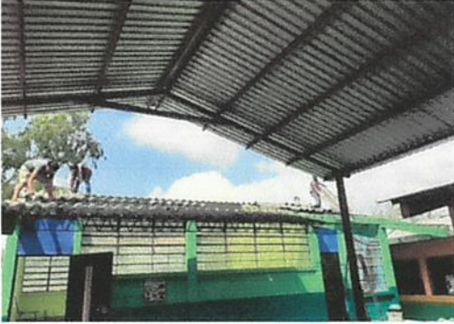
Foto 1: desmontaje de la lamina
