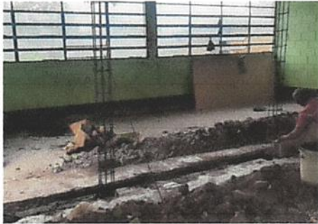
Foto 3: fundicion de la pared
