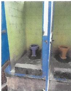
Foto 5: instalacion de sanitarios de concretos nuevos
