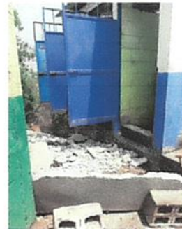
Foto 6: elaboracion de banqueta de concreto en sanitarios
