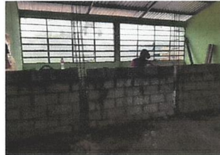
Foto 4: construccion de pared que divide el aula
