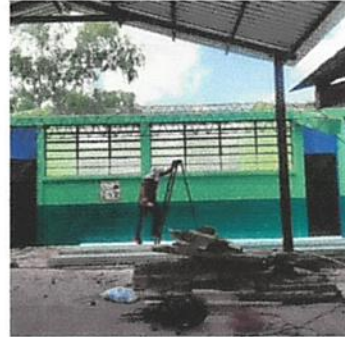
Foto 2: desmontaje de la estructura
